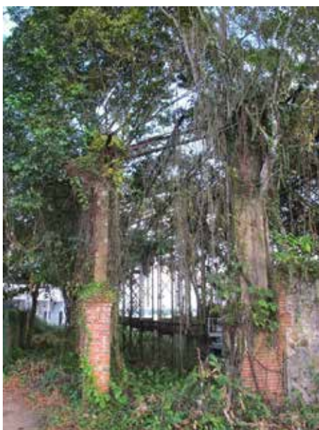
Figure 9: Vues partielles du pignon Est.
