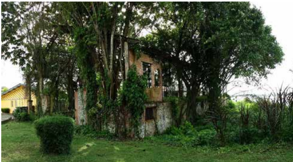
Figure 7: Vue générale de la façade Ouest des abords du fleuve
